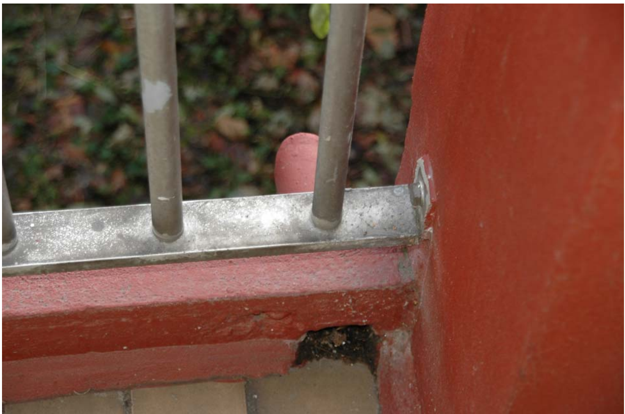
foto 8: Het aluminium balkonhek is verouderd maar nog wel in orde.
