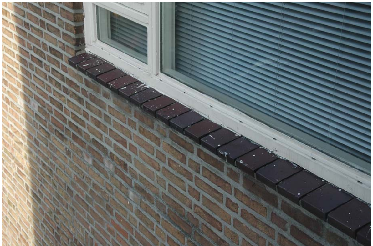
foto 6: De voegen van de waterslagen zijn eruit gespoeld.
