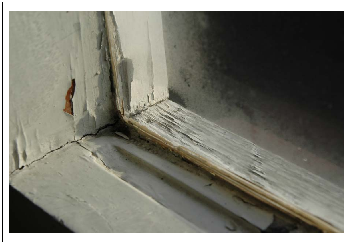
foto 10: Een van de kozijnen van het trappenhuis.
