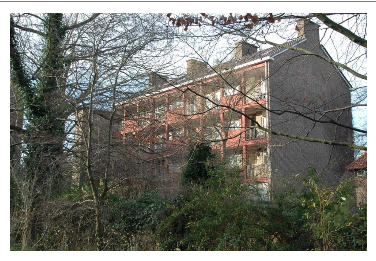
foto 2: De bestaande achtergevel en linker zijgevel
